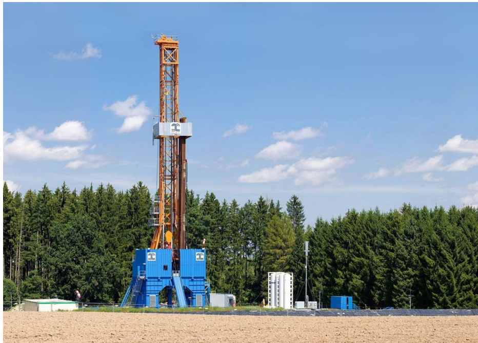
Photo: Richard Bartz, Wikimedia Commons, CC BY-SA 2.5 – https://commons.wikimedia.org/wiki/File:Geothermie_Bohrturm.jpg
